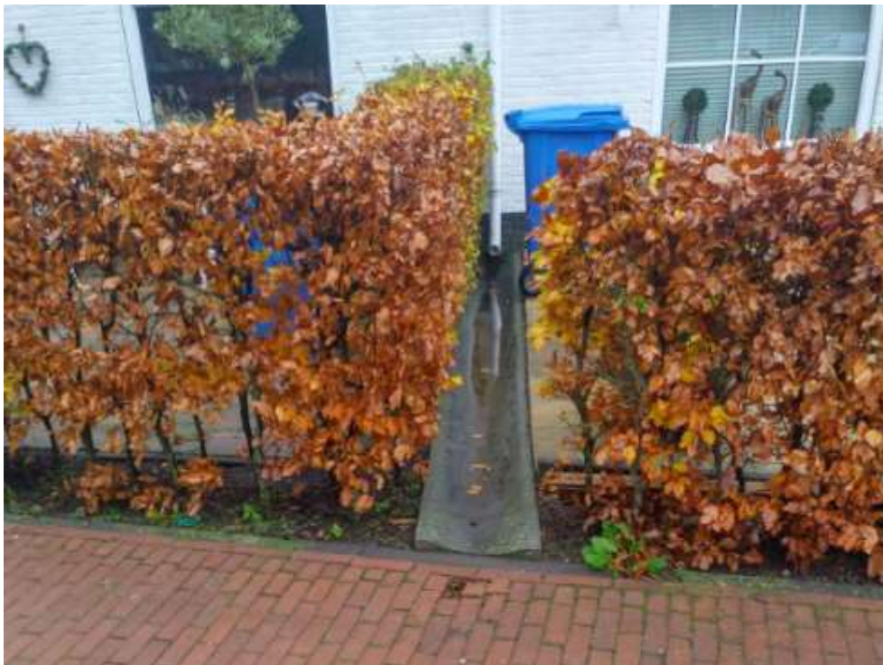
Afbeelding 4.5 Standaardoplossing 1 (voorkeur): oppervlakkige afstroming via goot
